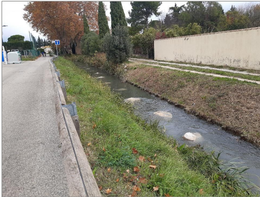
→ Diversification des habitats par enrochement sur le Grand Roannel
