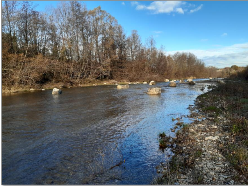
→ Diversification des habitats par enrochement sur l'Ouvèze
